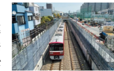
大師線連続立体交差事業
