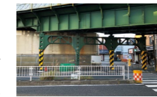
耐震補強工事施工予定箇所
